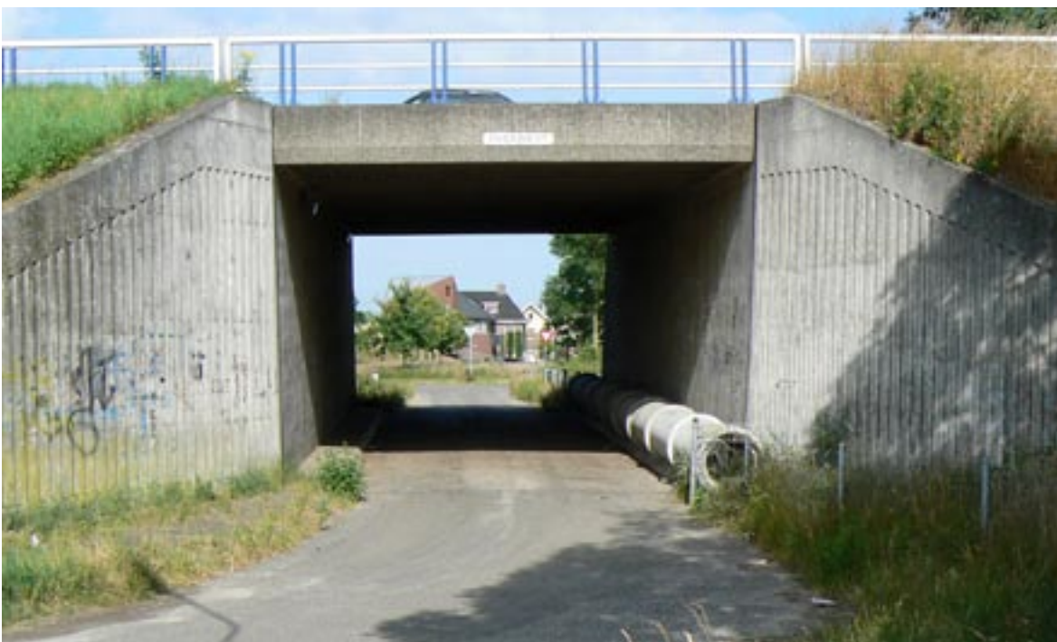
▲ Foto 5.9 Tunnelbuis onder viaduct Overbiest
