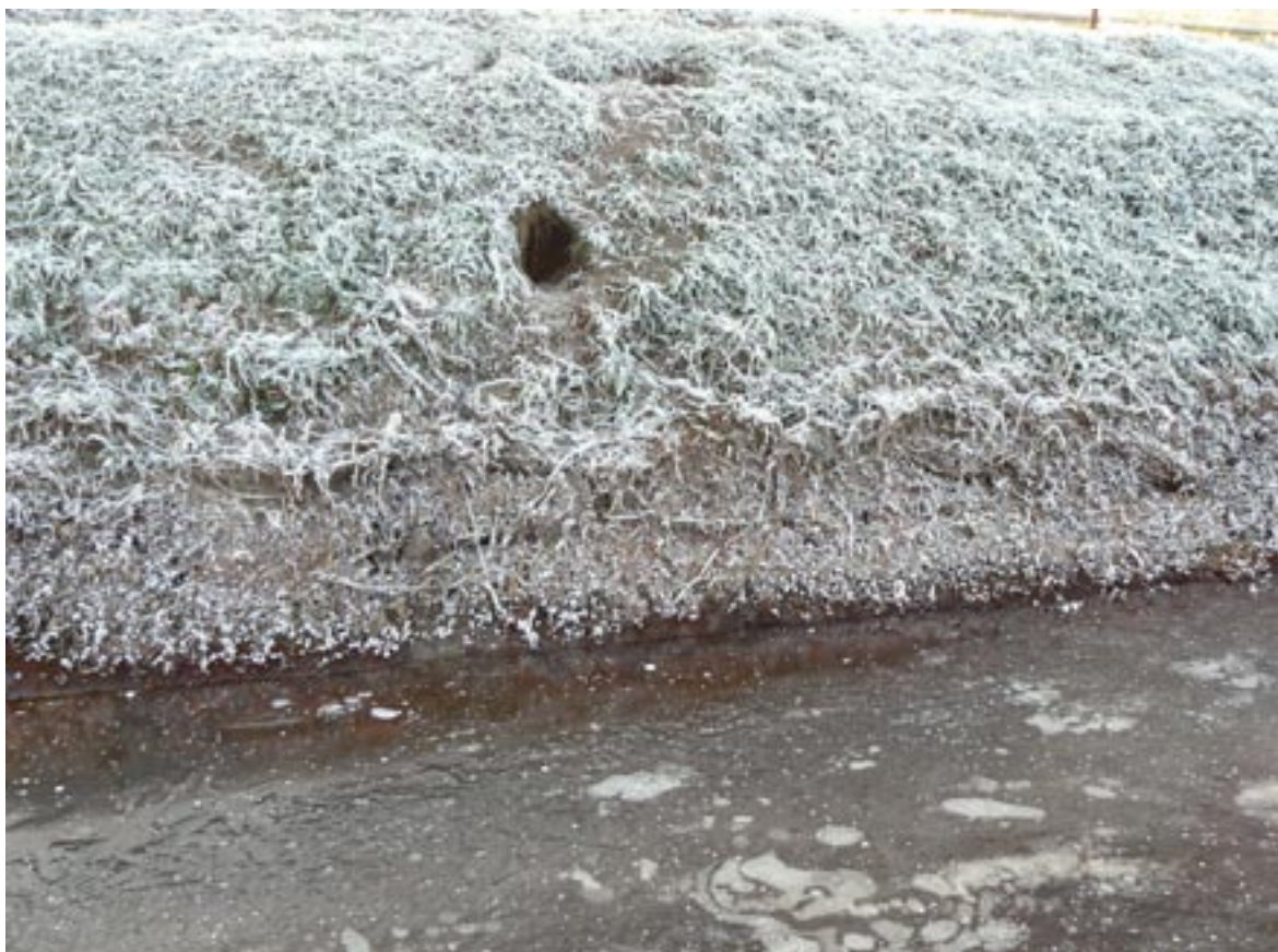
▲ Foto 5.19 Dassen-tunnel onder A73 met ingang in watervoerende sloot
