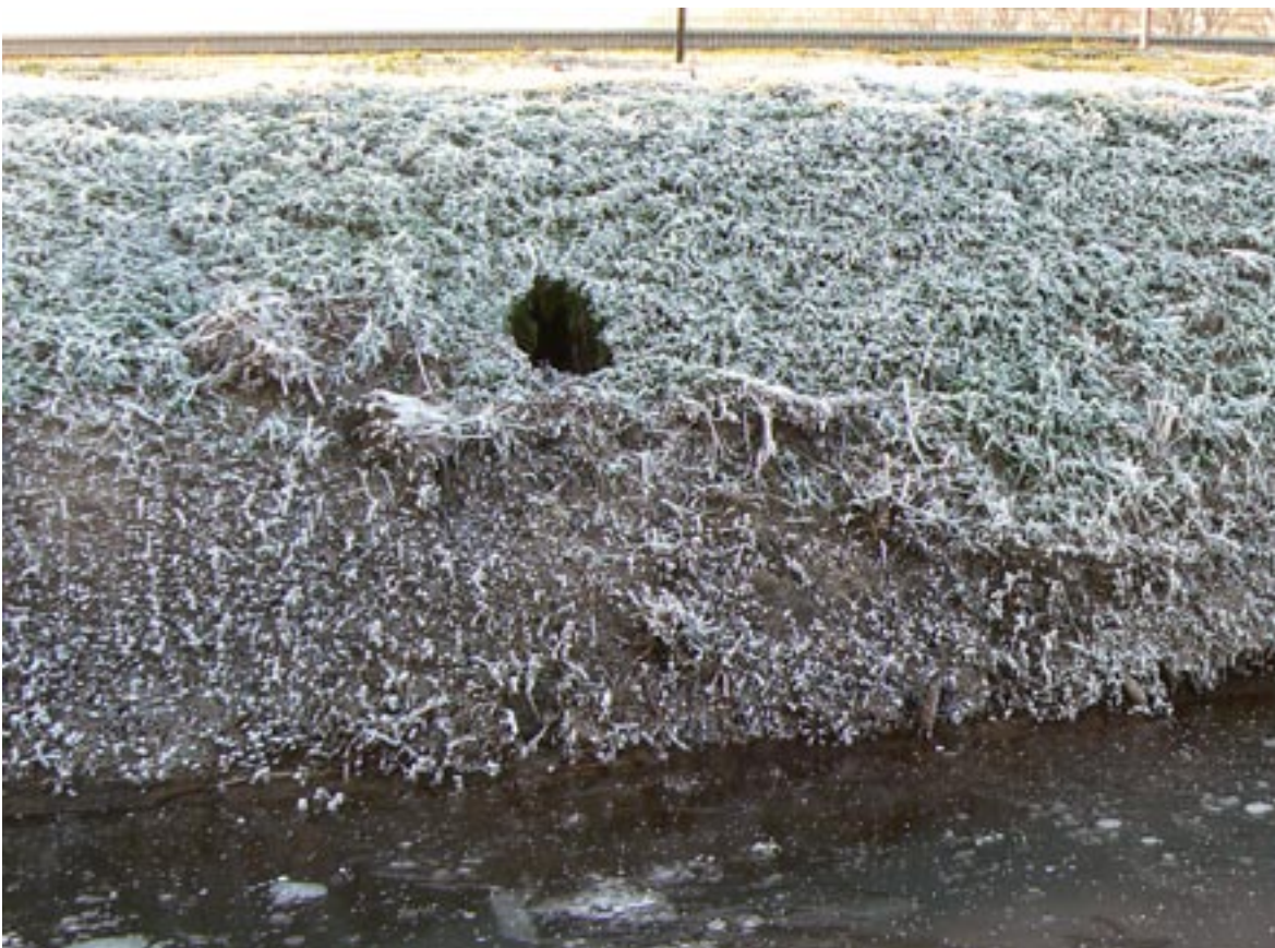
▲ Foto 5.18 Dassentunnel onder A73 met ingang in watervoerende sloot
