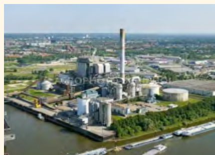
▲ De Amercentrale in Geertruidenberg. Een van de vijf kolengestookte centrales in Nederland.
