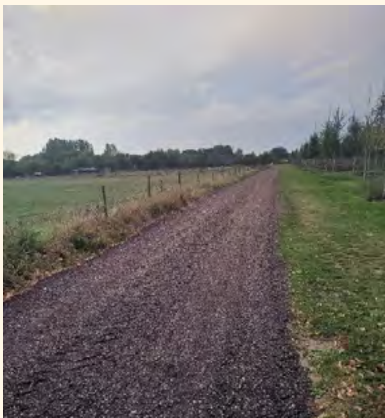
▲ Asfaltgranulaatweg "Blauwe steen" 2025
